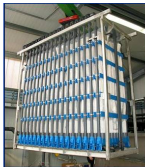
Figure 2. UF Module for MBR
